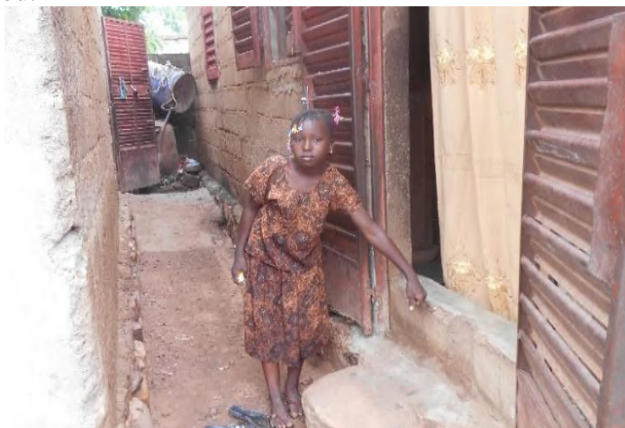
Photo 1 : Une fillette devant une concession dont l’entrée est surélevée pour empêcher la montée des eaux d’entrer dans le bâtiment à Banconi Source : Cliché, Oumar DEMBELE, Juillet 2016
