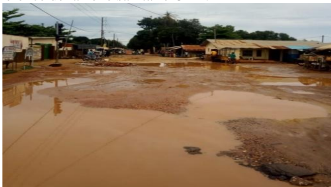
Photo 1 : Voie menant à l'Hôpital de zone OKT impraticable (Carrefour Gbèna dans l'arrondissement de Ouidah 2) Prise de vue: TCHINKOUN, juin 2021
