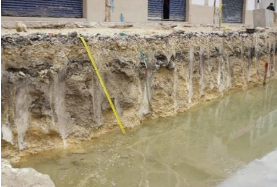
Figura 3. Acuífero expuesto en la zona centro de la ciudad de Chetumal Foto: P. Fragoso, 2015
