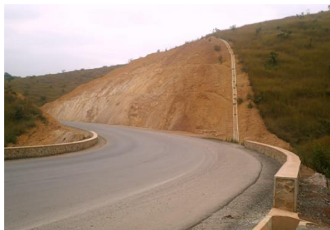
Photo 3 : caniveau et gardes fous aménagés le long de la route et sur le versant
