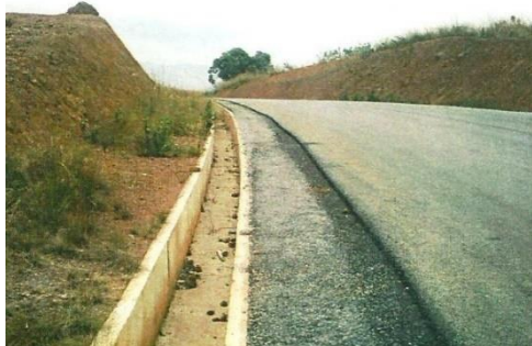
Photo 2 : Caniveau aménagé le long de la route.
