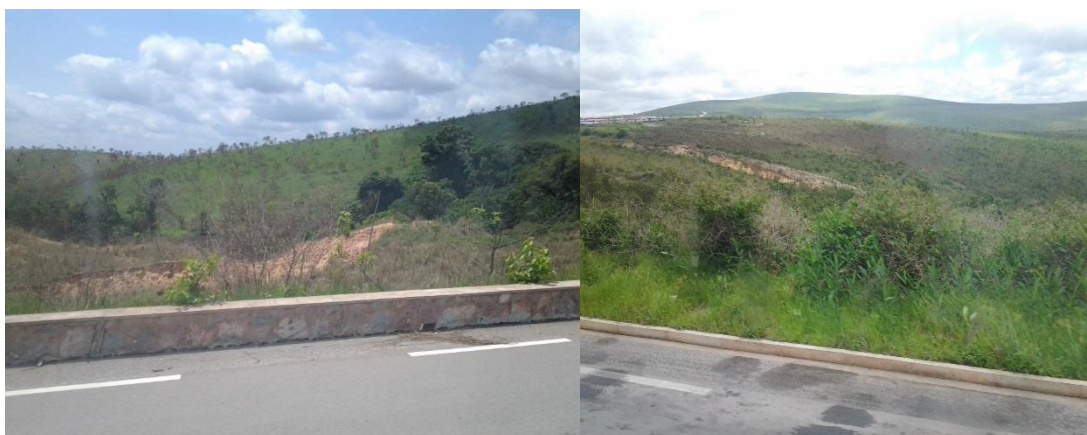
Photos 9 et 10 : sur ce versant une tête d'érosion très active dont l'évolution se fait par érosion régressive et constitue une menace sérieuse pour la route qui se situe désormais à 10 m.
