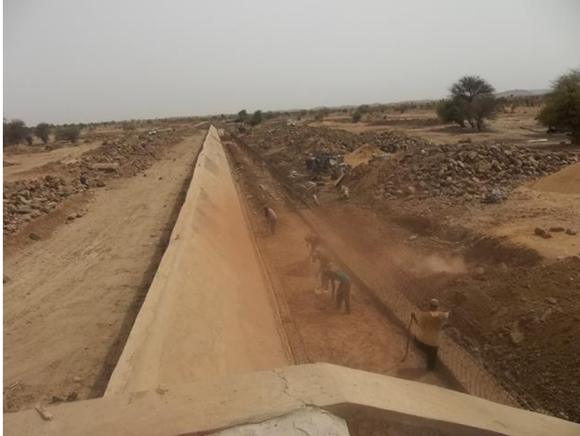
Figure 6: Evacuateur de crue en construction.
