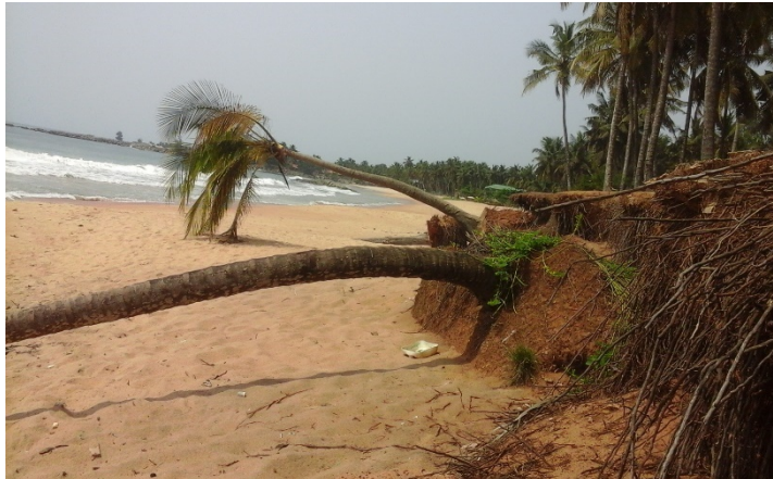
Photo 2: Des cocotiers inclinés sous l'action de l'érosion Source : OGOU Atsé, 2017
