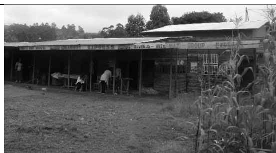
Photo 2 : Un site d'agence transformé en menuiserie
