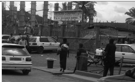
Photo 4 : Investissements immobiliers en cours dans le site d'une agence de voyage en centre-ville
