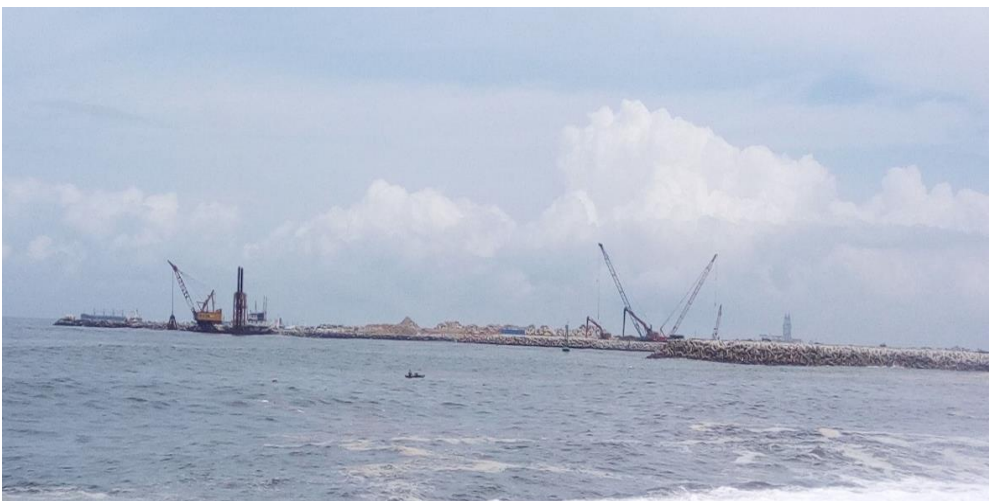
Photo 2: Les travaux d'élargissement et approfondissement du canal de Vridi (Cliché : Mouto, 2018)
