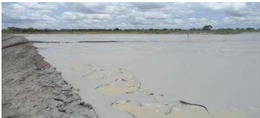
Figure 4: Vue de stockage des boues au niveau du parc à boue de Tongon (Source : SGS, 2014, p.71)
