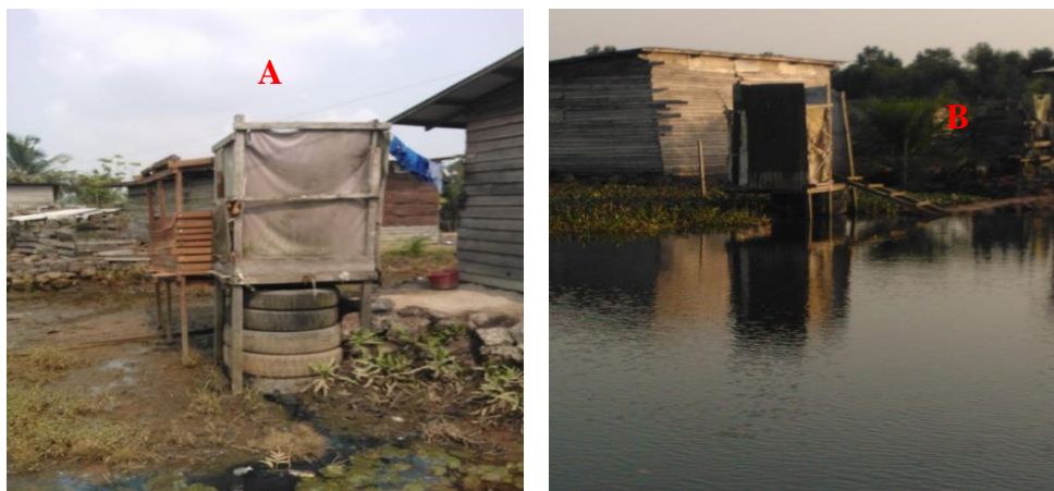
Figure 9 : Latrines sur pilotis à quelques mètres des puits. Cliché, Safougne, juillet 2015
