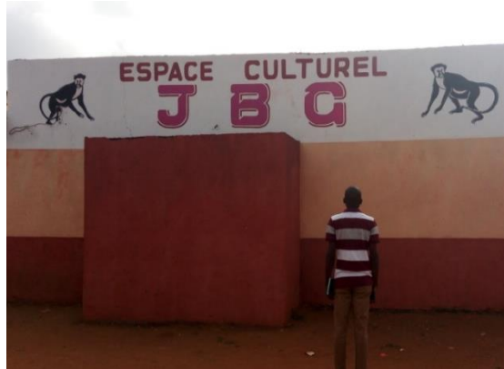
Figure 2 : Vue extérieure du bâtiment culturel du village Gbétitapéa
