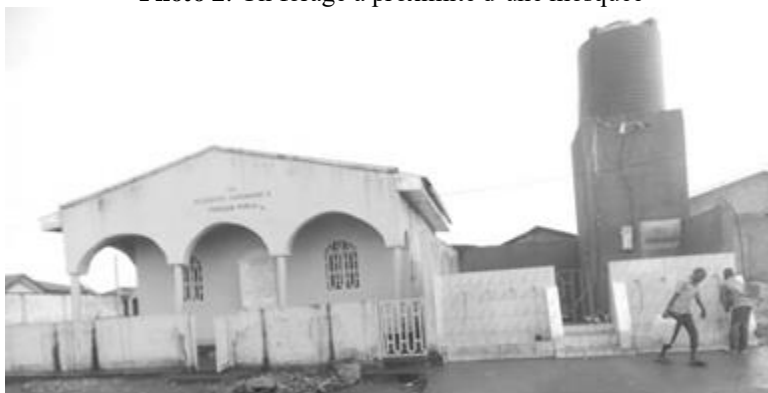
Photo 2. Un forage à proximité d'une mosquée
