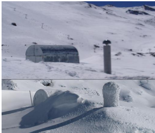
Figura 9. Estación GPS permanente NEVA en Sierra Nevada, Granada. La nieve cubre la antena con radomo y su entorno durante algunos meses produciendo variaciones en efecto multitrayectoria
