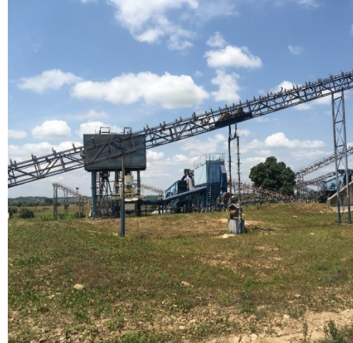
Photo 6 : Site de construction du barrage hydroélectrique d'Adjarala
