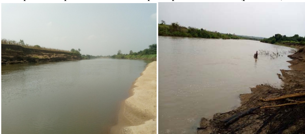
Photo 9 : Erosion de la berge du fleuve Mono
