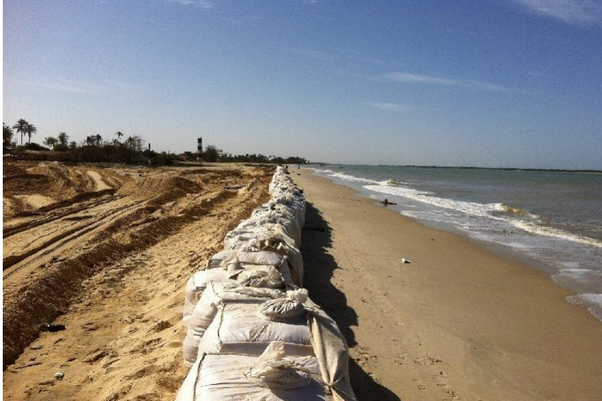
Photo 1. Travaux de rechargement de la plage de Gandiol en 2015 (source : DEEC, 2015)
