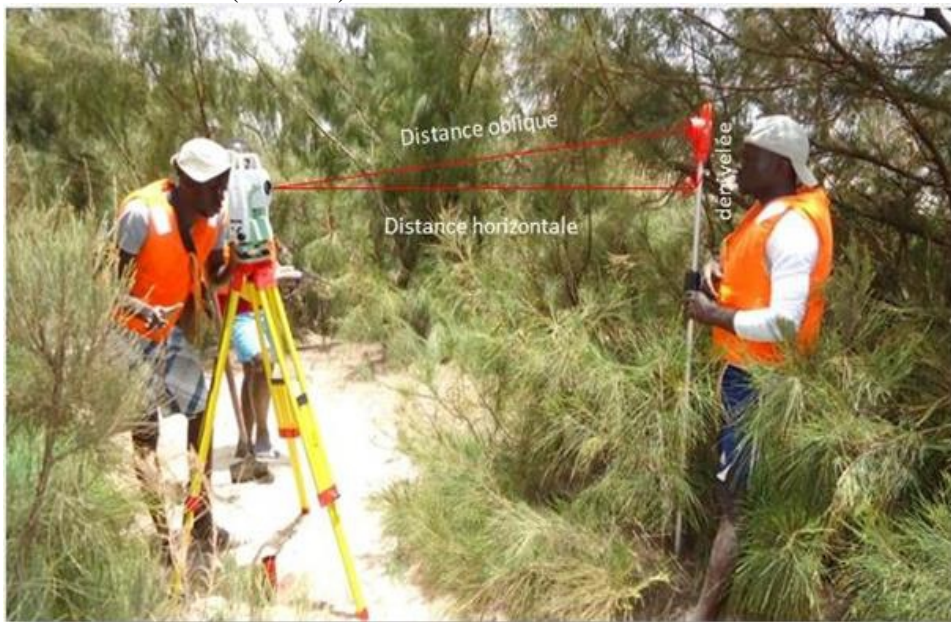
Photo 3. Mesure topographique avec la station totale
