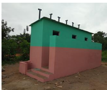
Photo 4 : Latrines ECOSAN EPP
