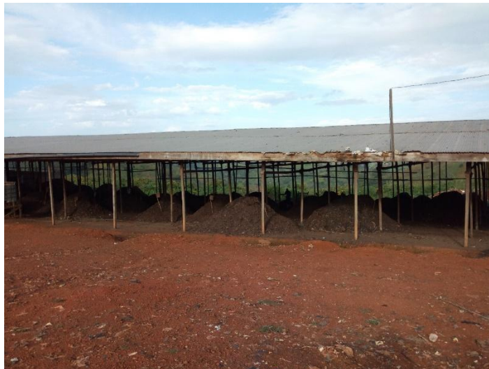
Figure 2. Vue d'ensemble de la plateforme de Siteu (Source : Garnier, 2018)
