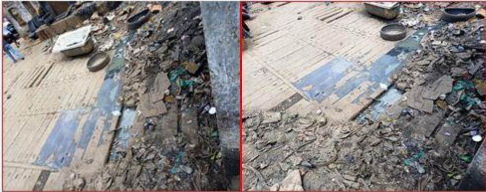
Figure 6. Station d'épuration ou fosse septique centrale du quartier Nyamugo (Commune de Kadutu, ville de Bukavu)
