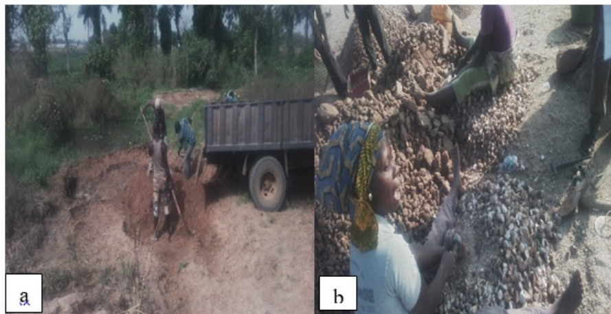
Planche 2 : Chargement de sable (a) et Concassage et tassage de gravier (b)
