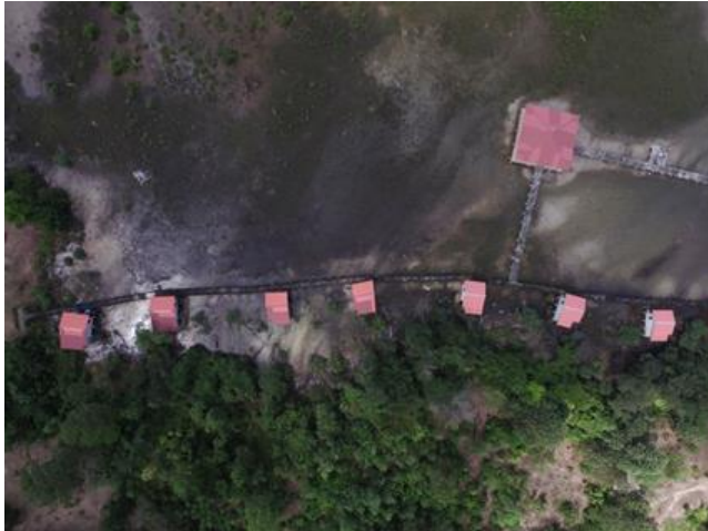
Photo 4 : Complexe hôtelier en chantier à Angondjé-Village Source : LAGRAC., 2020
