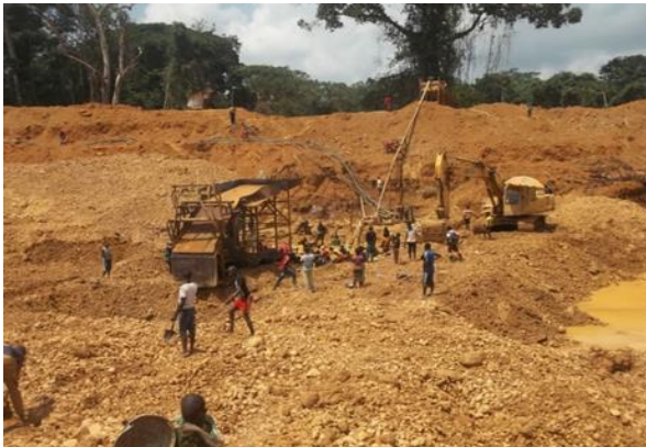
Photo 21. Présence des engins sur les sites (Maud 1)
