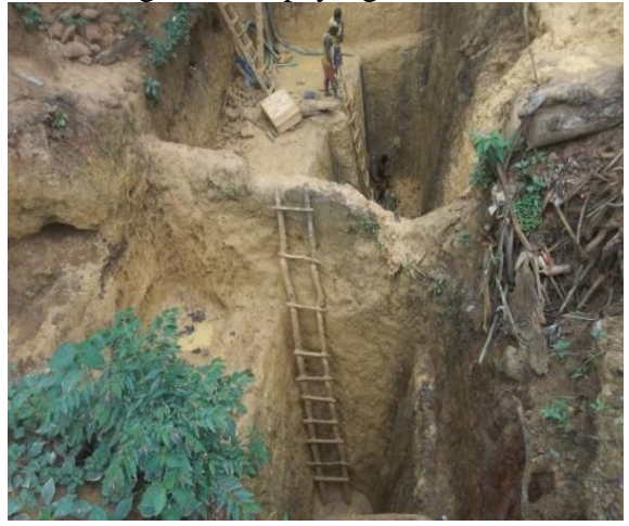
Photo 8. Excavation, site traditionnel (Ekokola)
