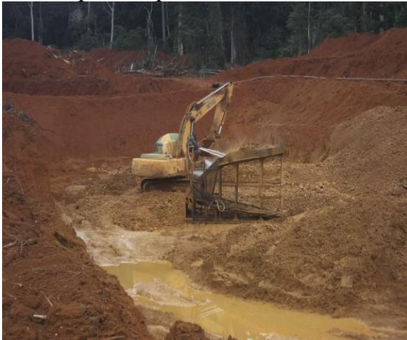
Photo 7. Excavation sur site semi-mécanisé (Maud 1)
