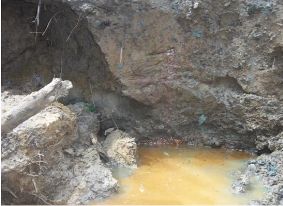
Photo 11. Eboulement, site traditionnel (Guinée)
