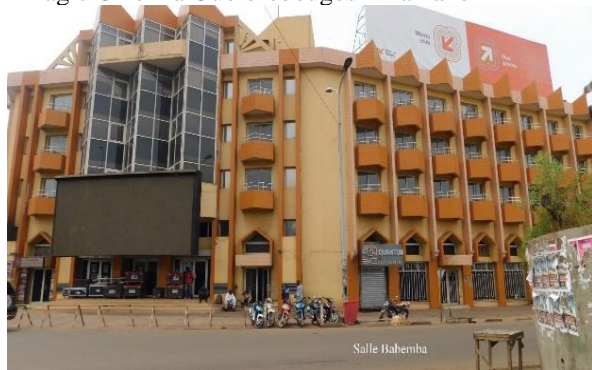
Photo 5. Immeuble « Babemba » et entrée de la salle « Magic Ciné » à Ouolofobougou - Bamako
