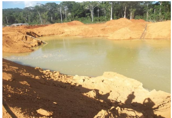
Photo 14. Stagnation des eaux dans un bassin de rétention
