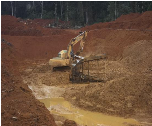
Photo 7. Excavation sur site semi-mécanisé (Maud 1)
