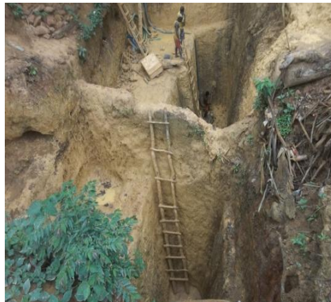
Photo 8. Excavation, site traditionnel (Ekokola)
