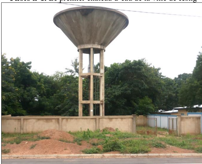
Photo n°1. Le premier château d'eau de la ville de Kong
