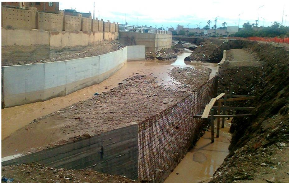
Photo 5: Travaux de construction de murs de protection et de renforcement des berges de l'oued
