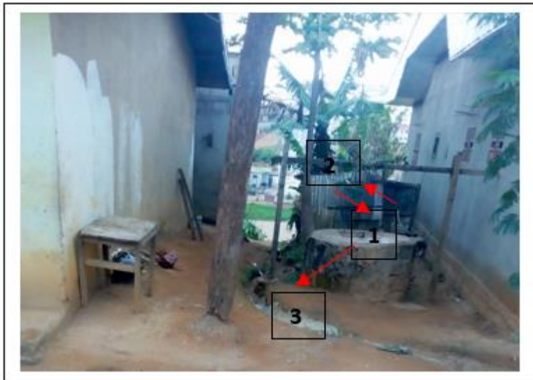
Photo 1 . Puits semi- aménagé situé à moins d'un mètre d'une latrine traditionnelle à fond perdu.
