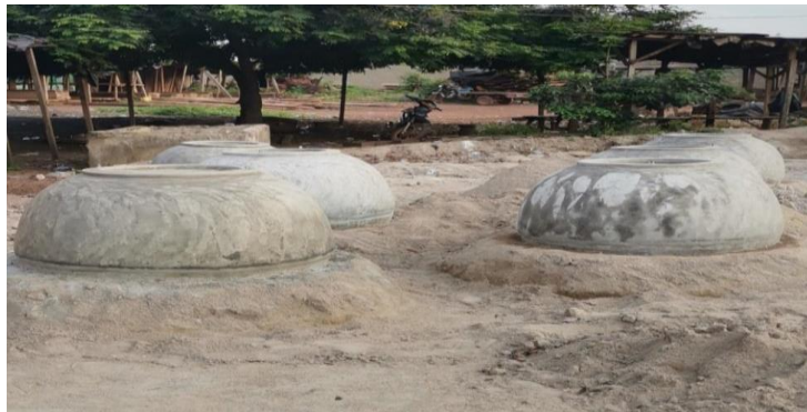
Photo 3. Un aperçu des réservoirs communément appelés « Jar » pour le stockage de l'eau sur les chantiers de construction
