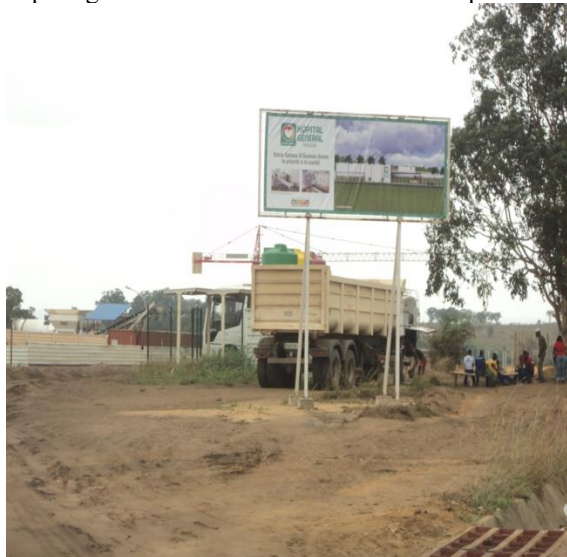
Photo 3. Hôpital général du Kouilou en construction par l'Etat à Loang
