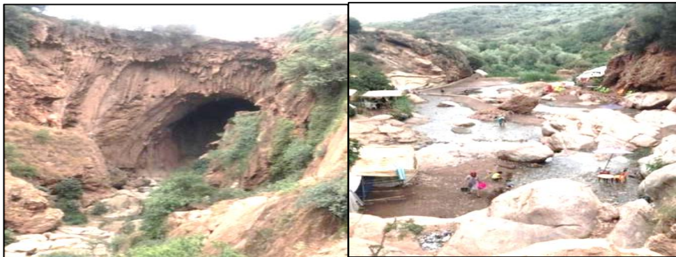
Figure 11. a. Face avale (Nord de l'arche vue vers le Sud) b. Gros bloc dans le lit de l'oued, au Nord de l'arche vers l'aval
