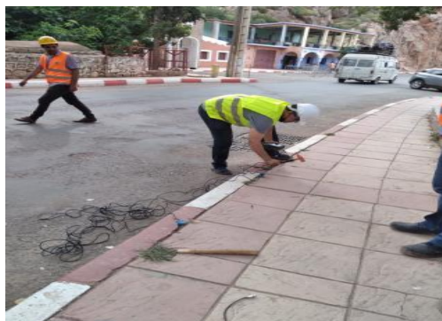
Figure 16. Installation des géophones reliés au sismographe
