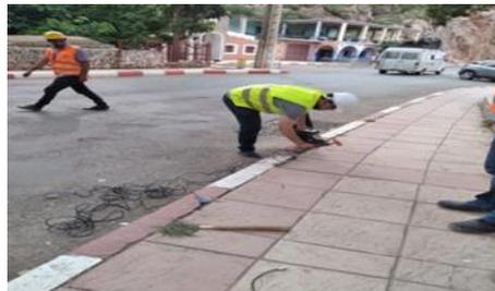
**Figure 16.** Installation des géophones reliés au sismographe
