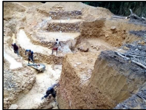
Photo 23 : Excavation en forme de gradins
