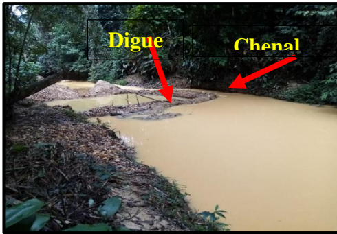
Photo 19 : Installation d'une digue et déviation du chenal principal d'un cours d'eau
