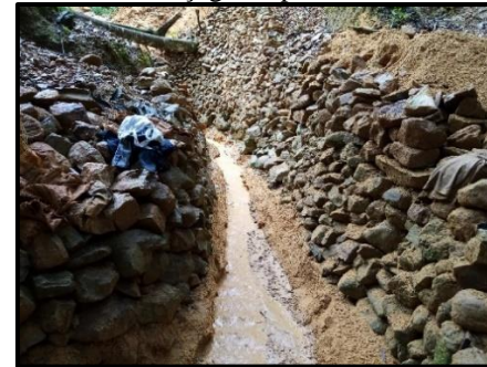
Photo 9 : Fonçage du puits, site artisanal
