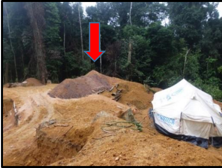
Photo 13 : Entassement de gravier avant lavage
