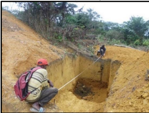
Photo 22 : Excavation de forme simple
