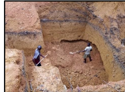
Photo 9 : Fonçage du puits, site artisanal
