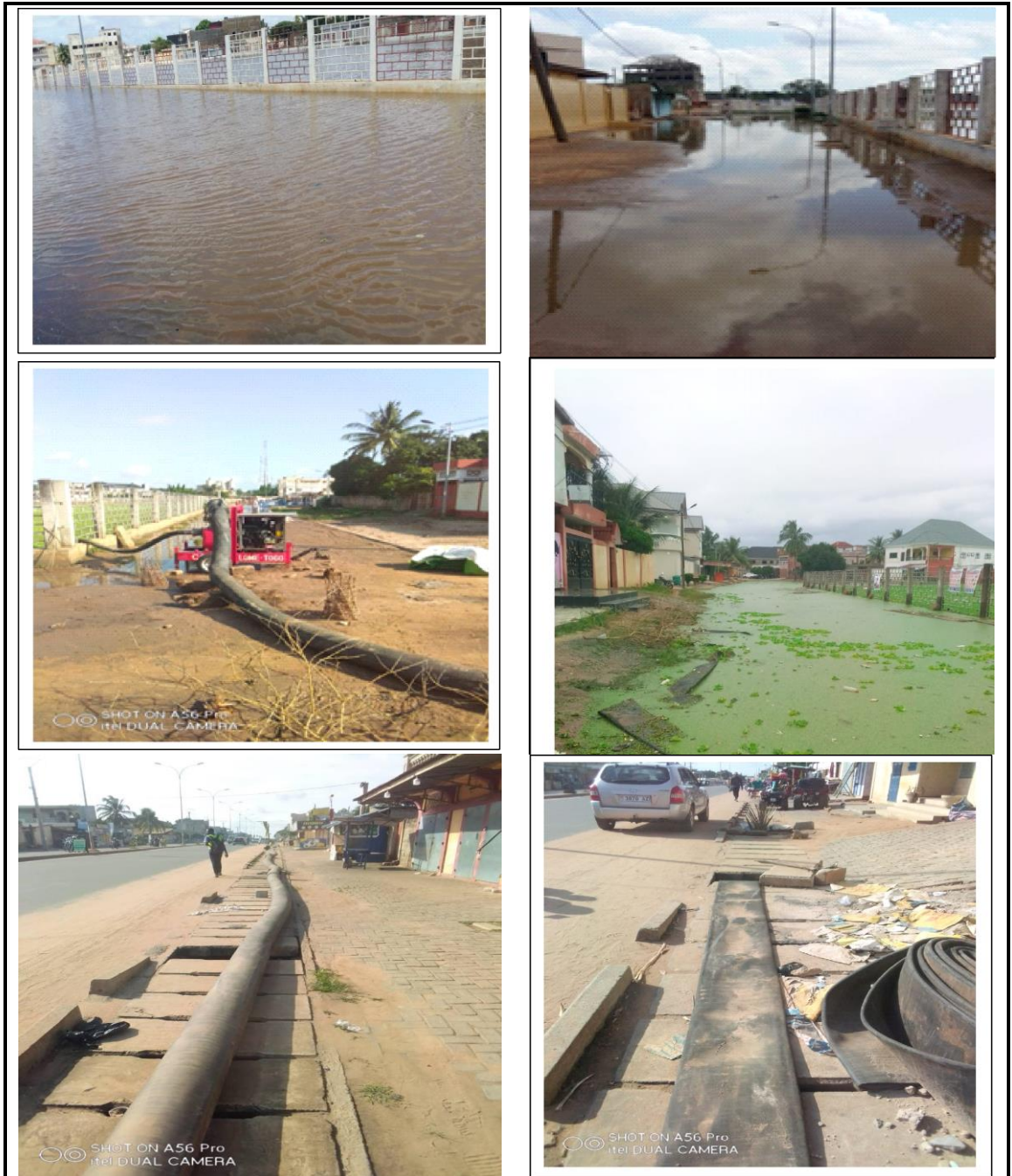
Figure 7 : Evacuation et drainage des eaux de débordement par pompage
