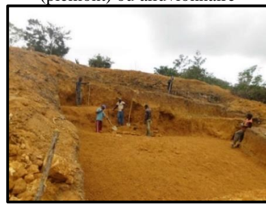
Photo 15 : Etalage de la couche minéralisée
