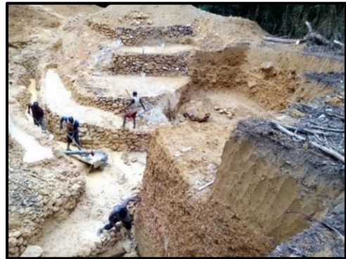
Photo 23 : Excavation en forme de gradins
