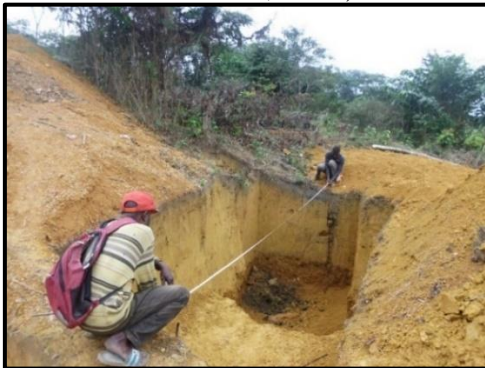
Photo 22 : Excavation de forme simple
