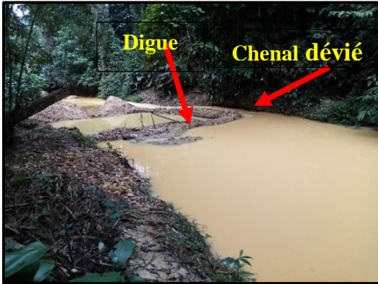
Photo 19 : Installation d'une digue et déviation du chenal principal d'un cours d'eau
