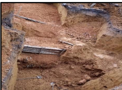
Photo 11 : Mur de soutènement dans un site éluvionnaire
