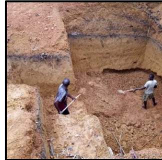
Photo 9 : Fonçage du puits, site artisanal
