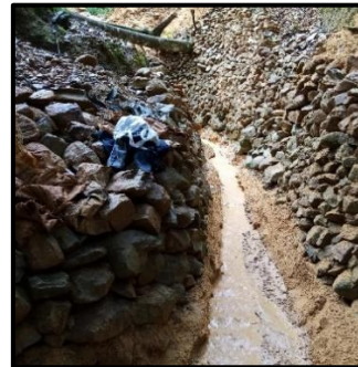
Photo 9 : Fonçage du puits, site artisanal
