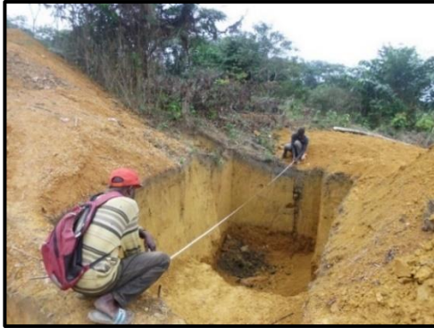
Photo 22 : Excavation de forme simple
