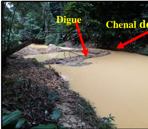
Photo 19 : Installation d'une digue et déviation du chenal principal d'un cours d'eau
