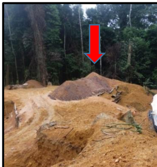
Photo 13 : Entassement de gravier avant lavage
