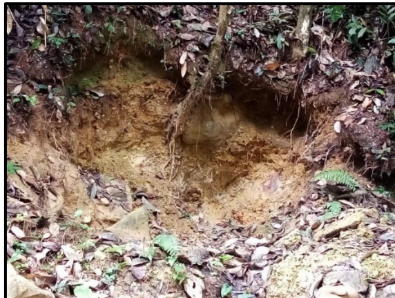
Photo 21 : Creusage de la berge d'un cours d'eau
