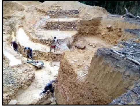
Photo 23 : Excavation en forme de gradins
