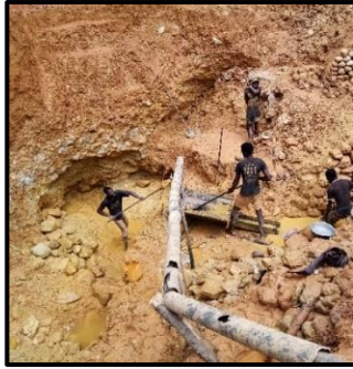
Photo 16 : Débourbage (Lavage à partir d'une caisse)
