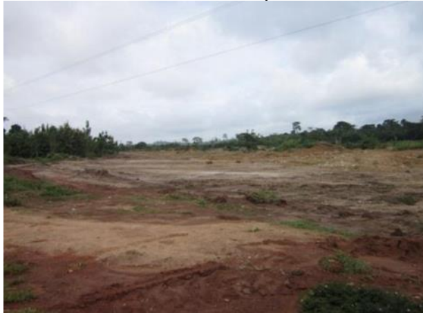
Photo 4 : Site minier de Hiré après réhabilitation
