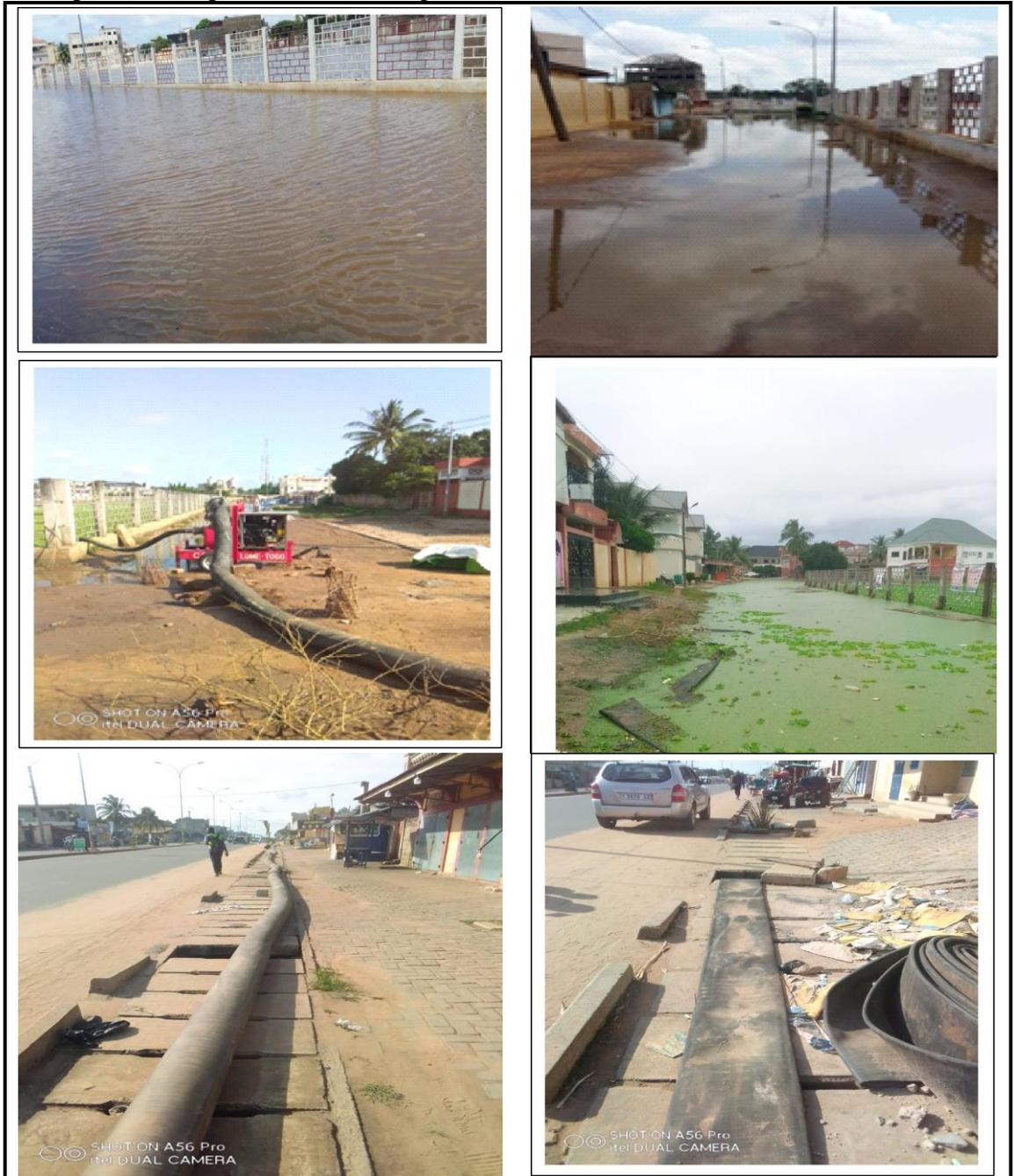
**Figure 7 :** Evacuation et drainage des eaux de débordement par pompage (Juin 2022)
