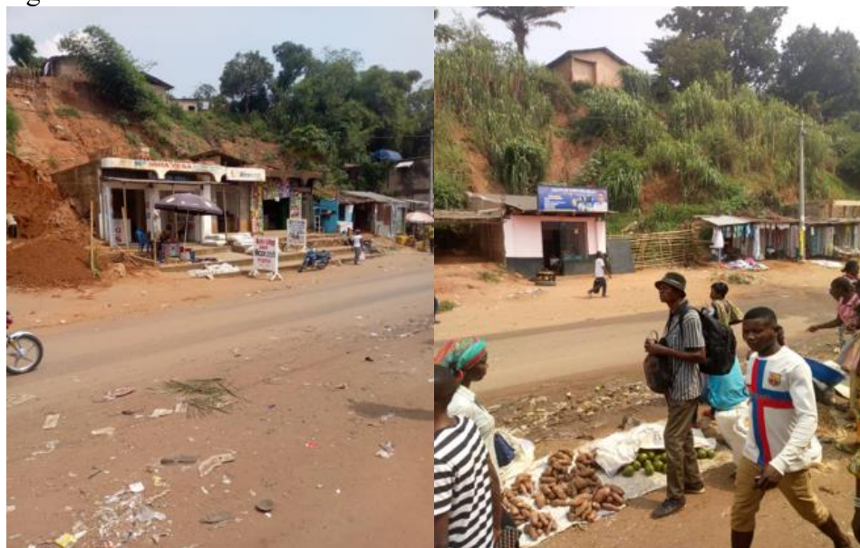
Figures 14 et 15: Maisons situées sur le talus et menacées par les glissements de terres
