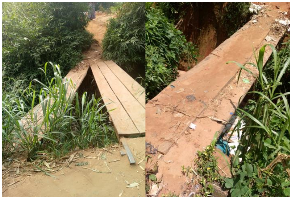
Figures 13 et 14: Les passerelles des avenues Lukotshi et Kongo
