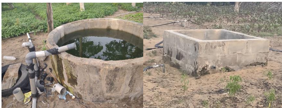
Figure 7 : Buse de stockage d'eau
