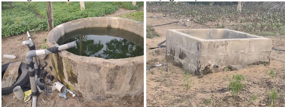
Figure 7 : Buse de stockage d'eau
