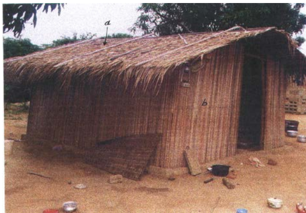
Figure 7 : Case construite avec les folioles (toiture) et les rachis (charpente et mur) de Raphia hookeri et des cordes de Calamus deërratus
