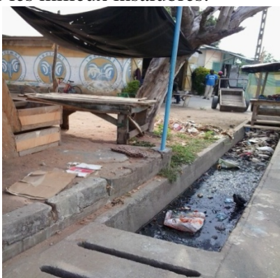
Photo 7: menuiserie en bordure de caniveau
