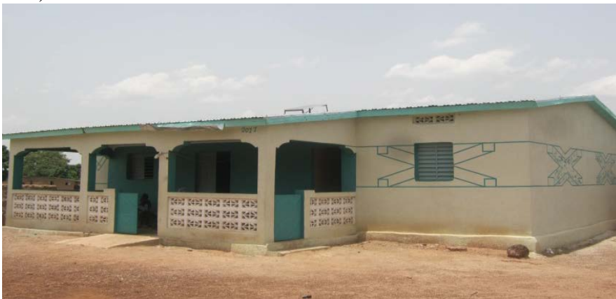
Photo 1 : Maison construite avec le lucre cotonnier dans le village de Diomantènè, chef-lieu de Zone de Production Agricole (ZPA) dans le secteur de Kadiolo (Cliché de l'auteur, 2012)
