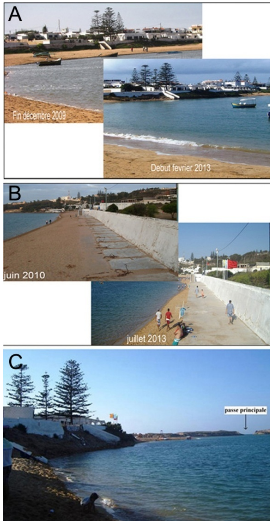
Planche 2.- (A) et (B) Dégradation de la plage de sable de la rive gauche entre décembre 2009 et février 2013 et entre juin 2010 et juillet 2013. (C) Déchaussement des constructions sur la rive gauche en juillet 2013
