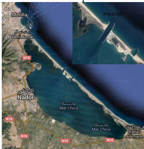
Fig. 1. La lagune de Nador (ou «Marchica») (Image©2013Google) avec zoom sur sa nouvelle passe d'entrée de la lagune. L'ancienne passe d'entrée (située à droite de la nouvelle passe d'entrée) est actuellement fermée.
