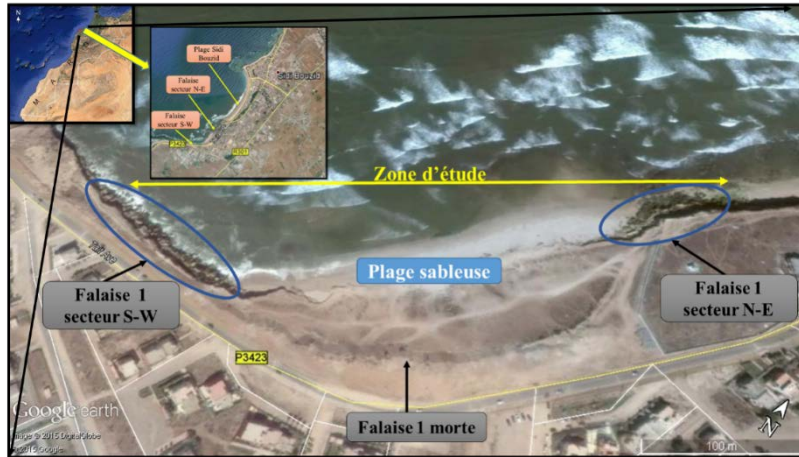
Figure 1: Situation géographique de la falaise de Sidi Bouzid (photos Google Earth).
