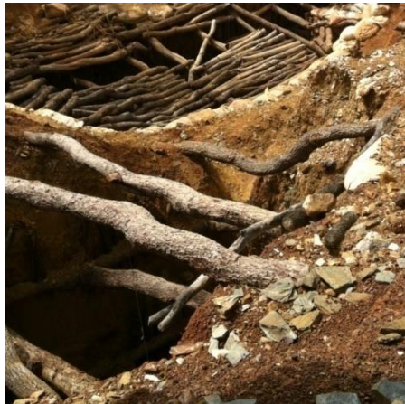
Photo 1: Fonçage d'un puits
