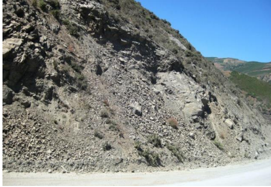
Figure 2. Alternance des roches dures avec des niveaux tendres
