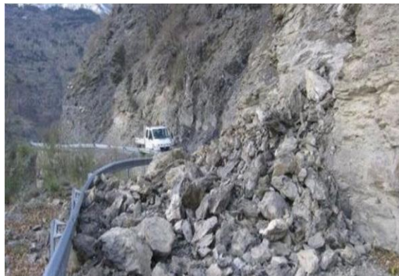
Figure 5. Eboulement rocheux a provoqué une interruption de la circulation routière
