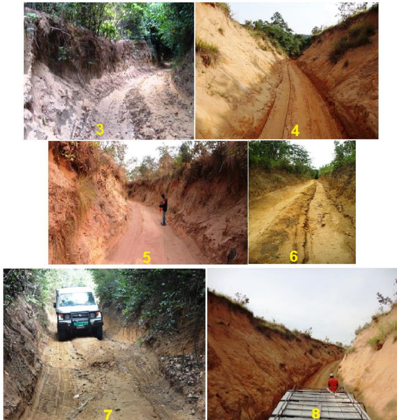
Photos 3 et 6 : Surcreusements rectangulaires sur la piste Koubola-Kibossi ; Photo 4 : Surcreusement en trapèze sur l'axe Koubola-Kibossi ; Photo 5 : Surcreusement rectangulaire vers Kibossi ; Photo 7 : surcreusements en formation sur la piste de Mayala ; situation d'un véhicule 4X4 contraint de suivre les ornières. Photo 8 véhicule coincé dans un surcreusement, sans marge de manœuvre sur la piste de Kibossi (8).
